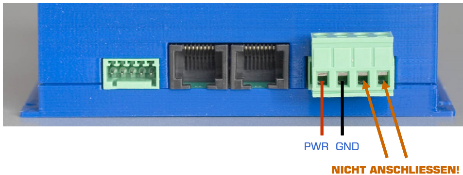
Abb. 12: Anschluss der Stromversorgung an den TM44
